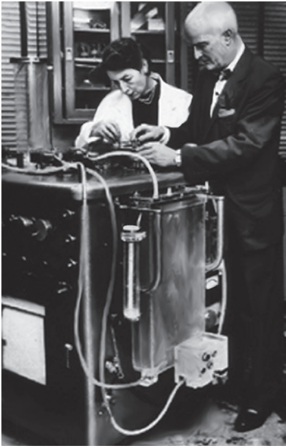
Fig. 50.1. Máquina diseñada por el cirujano John H. Gibbon para sustituir el trabajo del corazón y los pulmones usando un oxigenador de burbujas y una bomba peristáltica.
